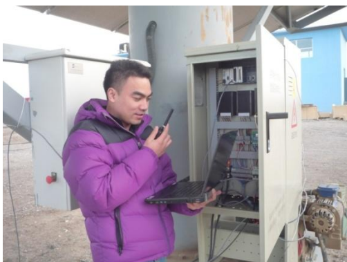
图 6. 与汇流箱对应的 CompactRIO 数据采集监控系统
