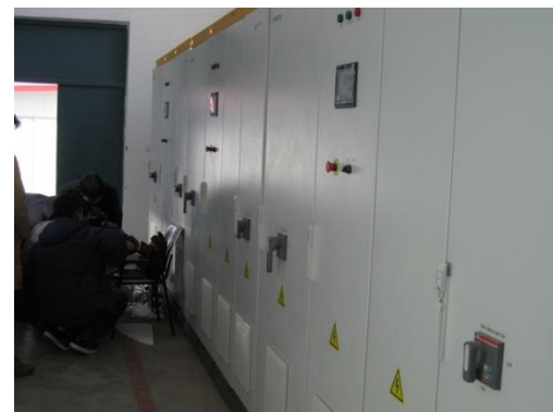
图 7. 中心监控室直控柜、逆变器和监控系统
