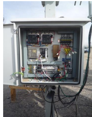
图 5. 光伏型发电组件汇流箱
