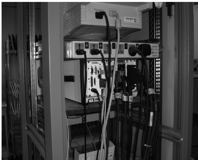
图6 19寸控制柜中的PXI控制器及NI板卡
