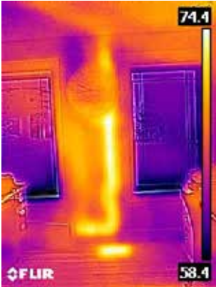
墙壁中的热水排水管
