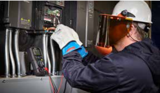
利用VFD模式对变频驱动进行故障排除
