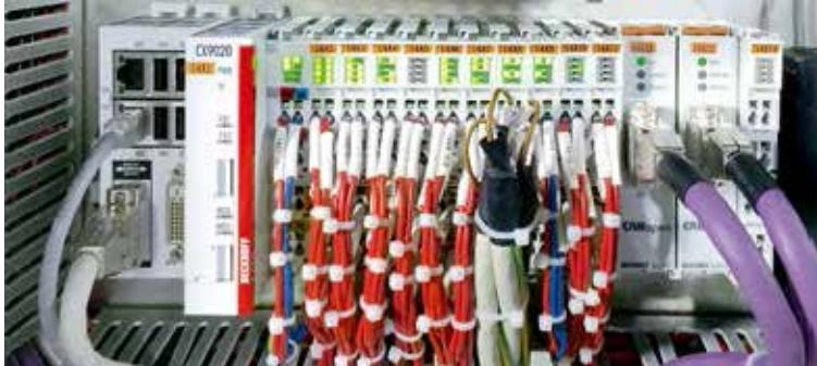
同时变桨系统中使用 CANopen 从站端子模块 EL6751 实现变桨系统的主控制器 CX9020 与风机主控制器之间的通讯。中央控制器 CX9020 和三个轴驱动器之间通过 EL6751 模块实现 CANopen 通讯连接。CX9020 集成的 RS485 接口用于监控后备电源充电器的状态信息。此外，在线访问功能，例如用于在变桨系统出故障时进行软件更新和故障分析，可以通过嵌入式控制器的网络接口实现。
