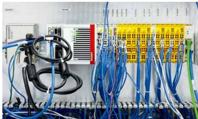
插接有 EtherCAT 端子模块和 TwinSAFE 端子模块的高性能 CX5140 嵌入式控制器节省了控制柜的安装空间，确保实现快速高精度同步控制
