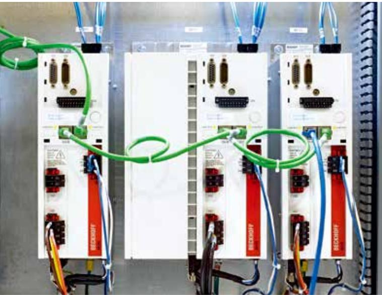
用于实现三轴协同运动系统的 AX5000 紧凑型伺服驱动器可轻松安装到体积较小的控制柜中
