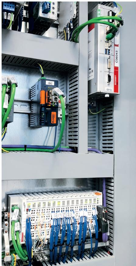
Aida 冲压生产线内的每个工艺步骤都由安装有 TwinCAT 软件的工业 PC（上图）和各种 EtherCAT 端子模块（下图）控制
