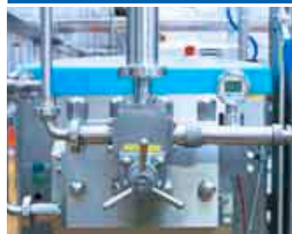
搅拌过程中进行高压测量
