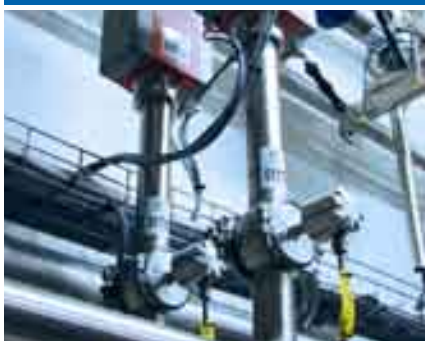
储罐中的温度测量
