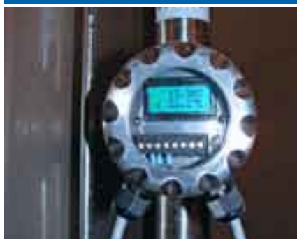
测量现场清洗（CIP）过程中的最优溶液浓度
