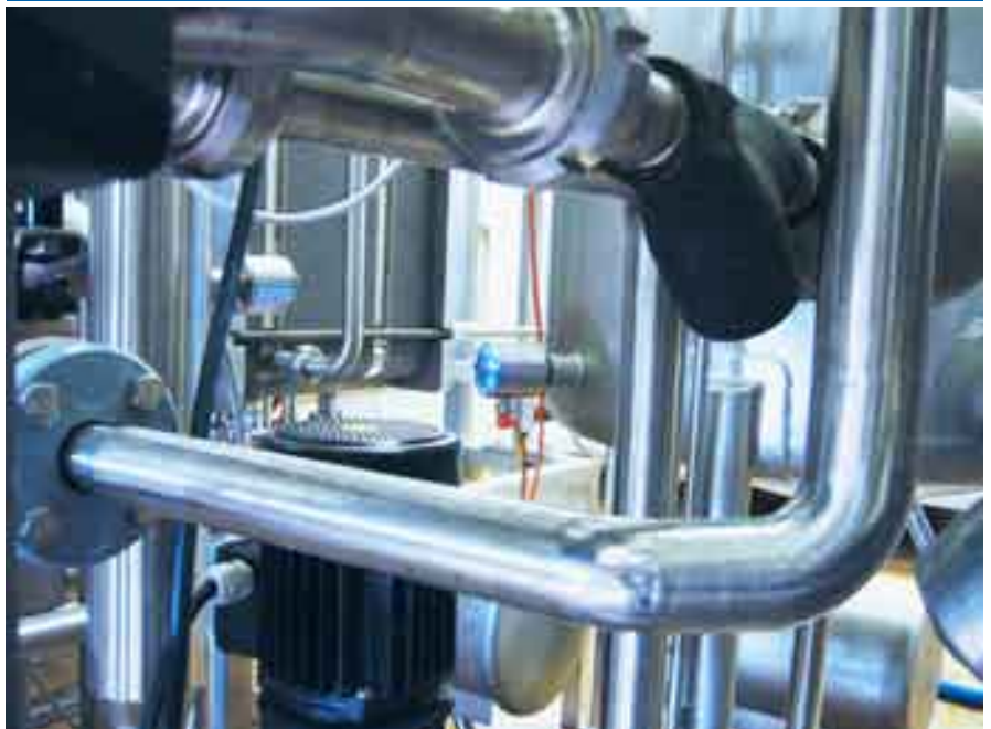
缓冲液槽中的高 / 低液位监控
