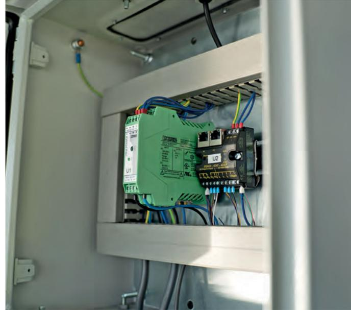
现场中的迷你控制器：紧凑型FEN20 I/O模块（右）使用其集成的AGREE逻辑，将激光扫描仪的开关信号转换为信号指示器的4种状态
