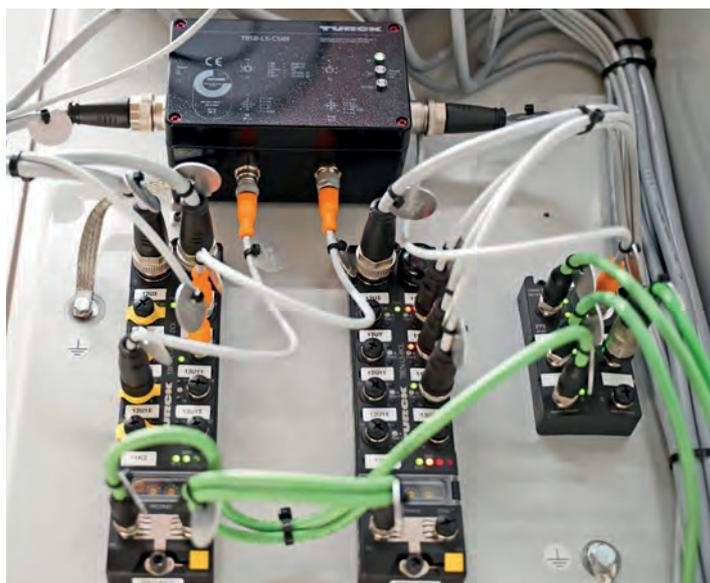
该安全应用由TBPN（左）控制，用于工厂中的测试。Profisafe控制器则在最终客户侧接管应用的实际运行。所有连接至IO-Link master（中）的执行器都通过TBSB Box进行安全关断
