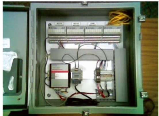
XM模块安装示意图
