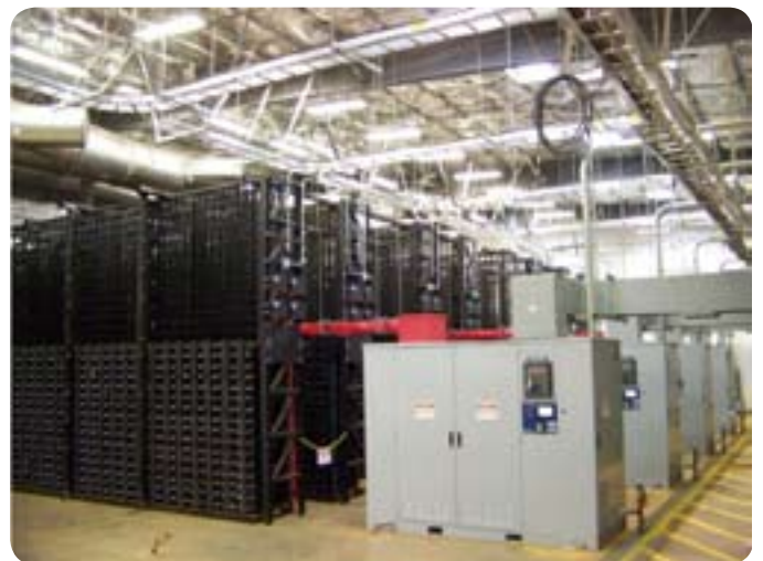
图3. XP能源系统的分布式架构具备可扩展性，通过增加更多的电池/逆变器单元可将规模扩展至多兆瓦/兆瓦时
