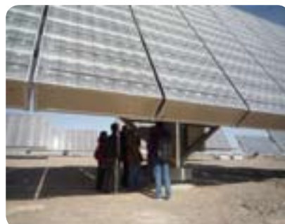
图4. 聚光式光伏型发电组件及其控制、汇流、测试设备
